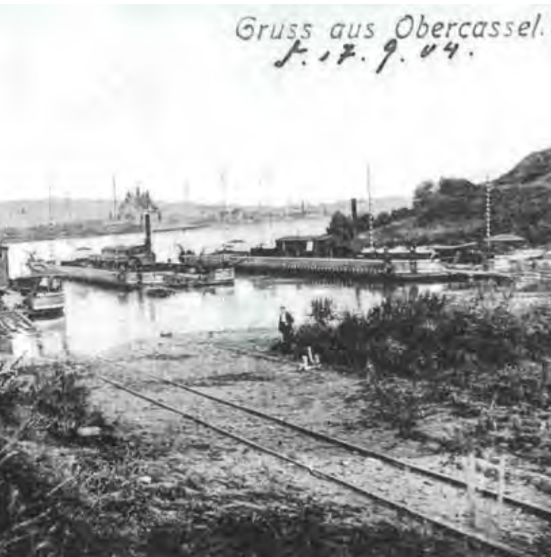
mit Blick auf das Bonner Ufer Gronau mit der
