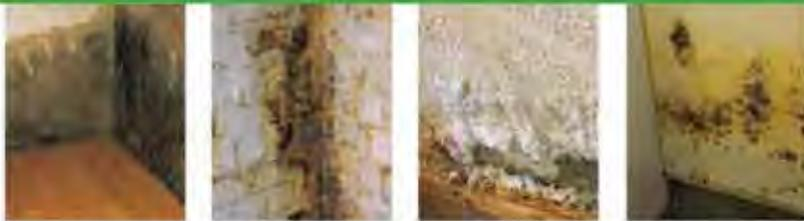
Defekte Horizontalsperre      Querdurchfeuchtung      Ausblühungen      Schimmelbefall
