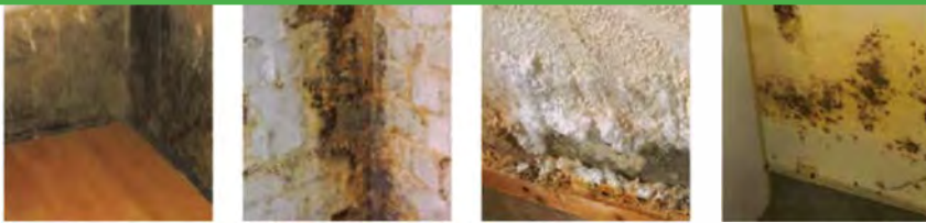
Defekte Horizontalsperre
