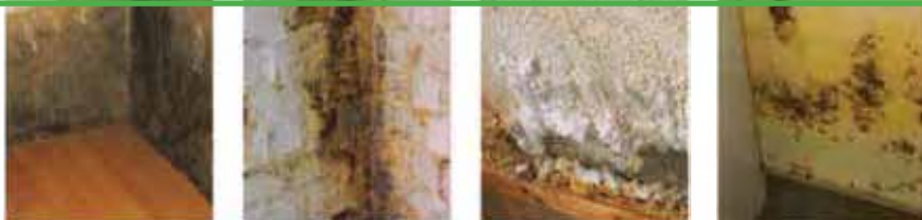
Defekte Horizontalsperre
