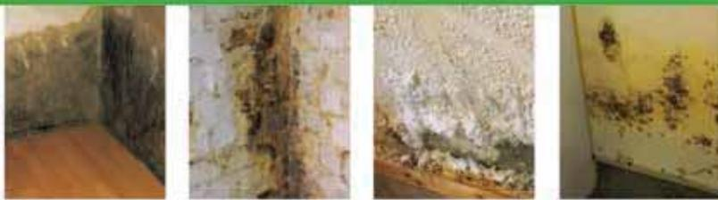
Defekte Horizontalsperre      Querdurchfeuchtung      Ausblühungen      Schimmelbefall
