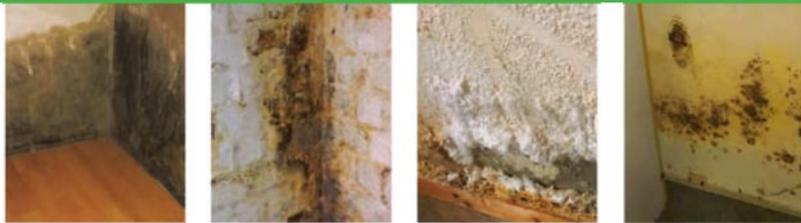
Defekte Horizontalsperre      Querdurchfeuchtung      Ausblühungen      Schimmelbefall
