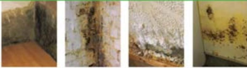
Defekte Horizontalsperre    Querdurchfeuchtung    Ausblühungen    Schimmelbefall
